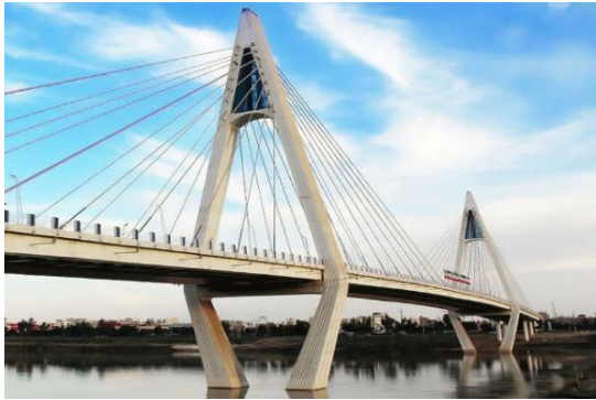
شکل ۲- پل هشتم با پایه‌های مایل ساخته شده در شهر اهواز، ایران
